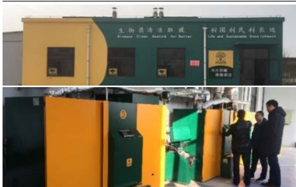
图 3-10 奥地利 KWB 生物质锅炉系统
