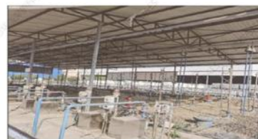
✓ 液态VOCs物料卸装管道
