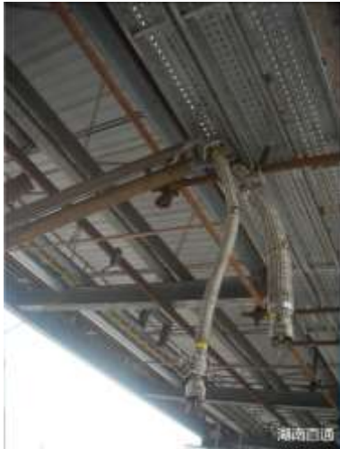
快速接头连接汽车顶部密闭装载
