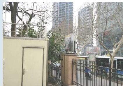
机动车排气污染道路自动监测站
