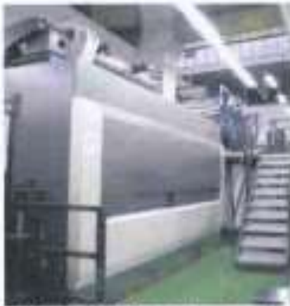
触媒燃烧方式 触媒燃烧方式
