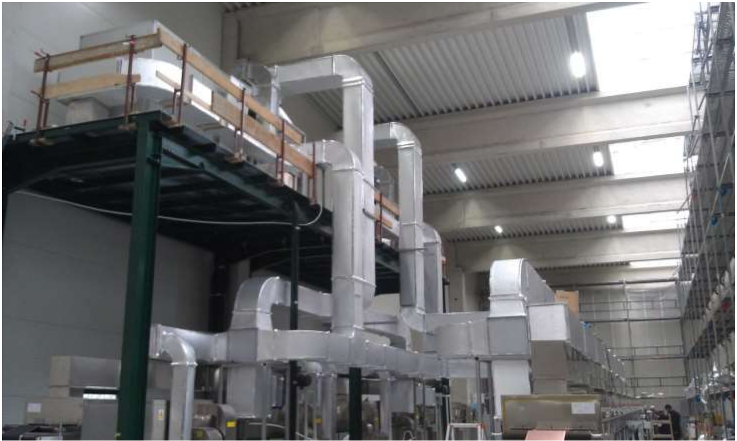
安装在德国ECC BATTERY 公司的有机溶剂回收装置
