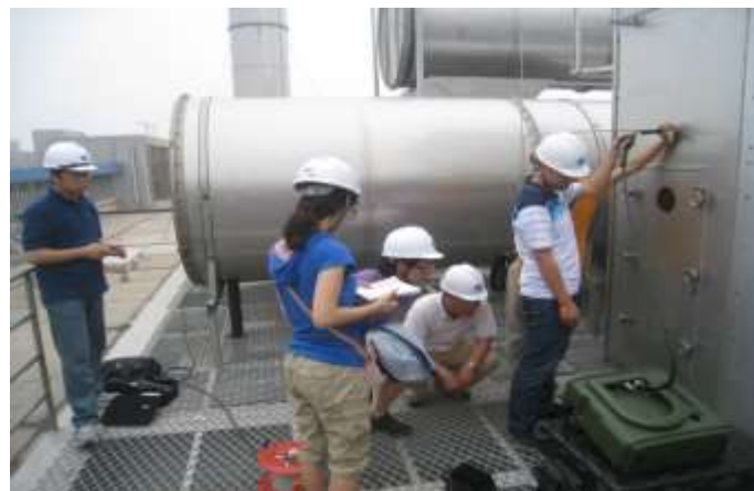
半导体及光电企业安装沸石转轮吸附浓缩+燃烧
