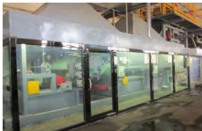
防水卷材企业安装密闭收集处理装置
