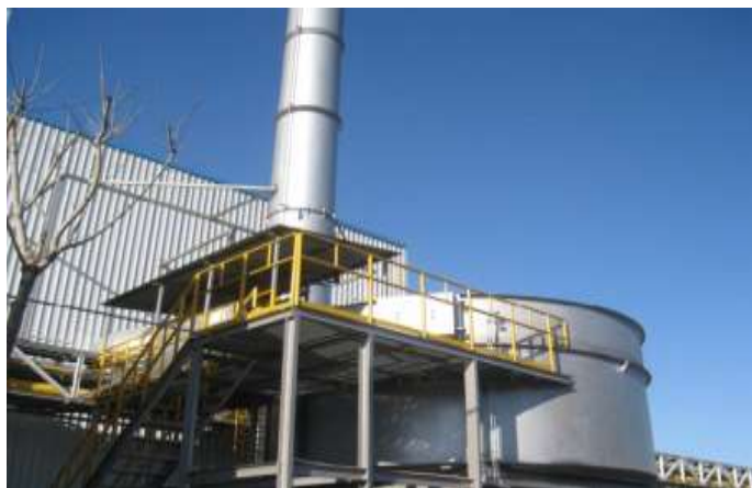
汽车制造行业安装RTO装置
