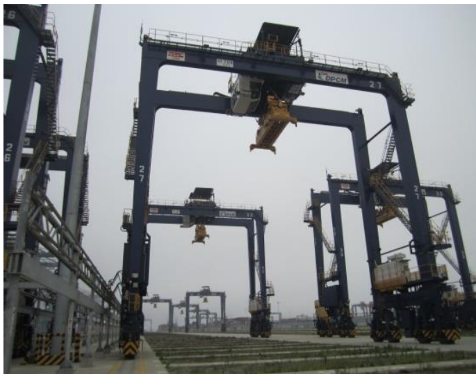
集装箱陆桥油改电
